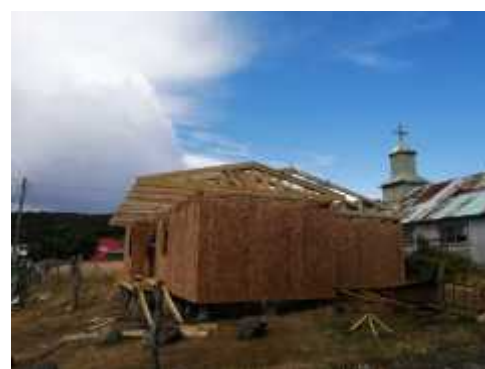
Construcción Sala Multiuso Sector de San José
