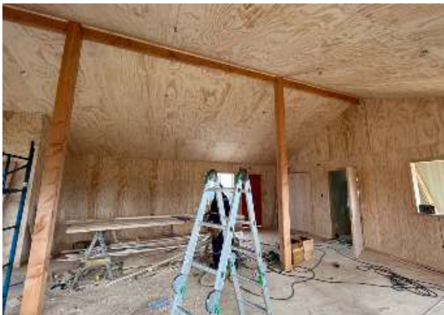
Avance de obra Sede club deportivo Bellavista Pio Pio.
