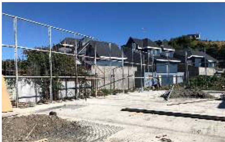
Avance de obra Reposición Multicancha Villa Queilen
