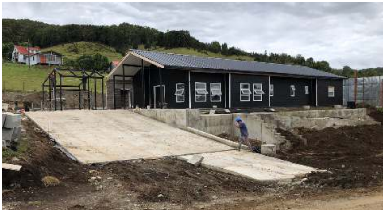
Avance de obra Posta de salud rural de Nepuél.
