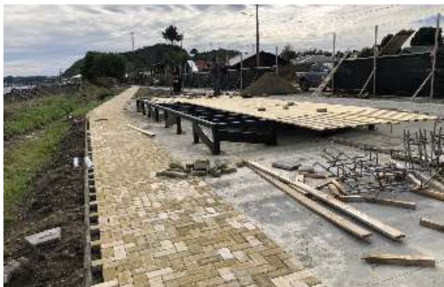
Avance de obra Mejoramiento integral costanera.
