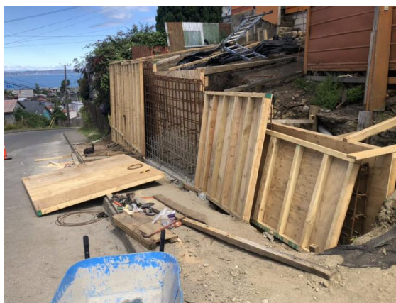
Construcción Muro contención para protección de calle Kennedy.
