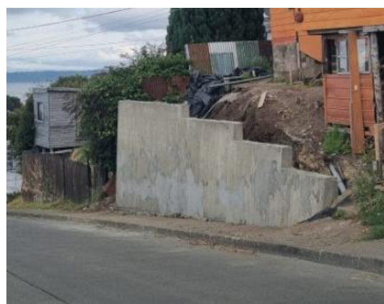
Construcción Muro contención para protección de calle Kennedy.
