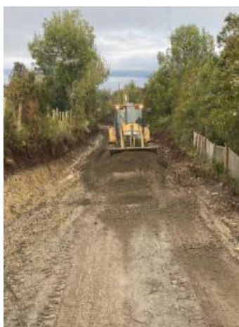
Recargue, enchanche y canalización de aguas en camino de Pureo Alto
